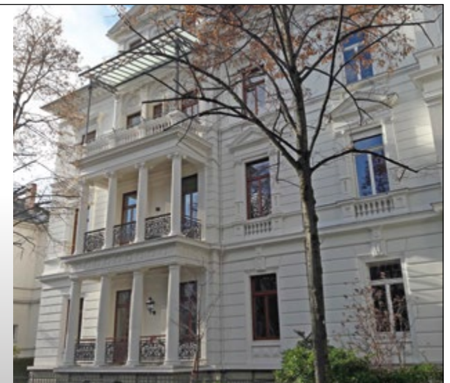
Umbau und Sanierung Villa Blumenstraße
